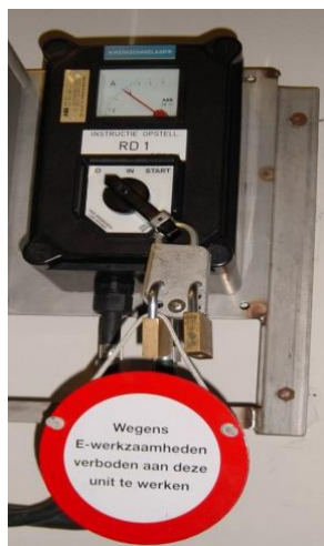
Figuur 4. Werkschakelaar en vergrendelde werkschakelaar incl. waarschuwbordje.
